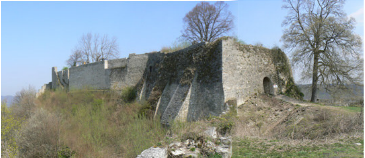
Kernanlage von Süden
