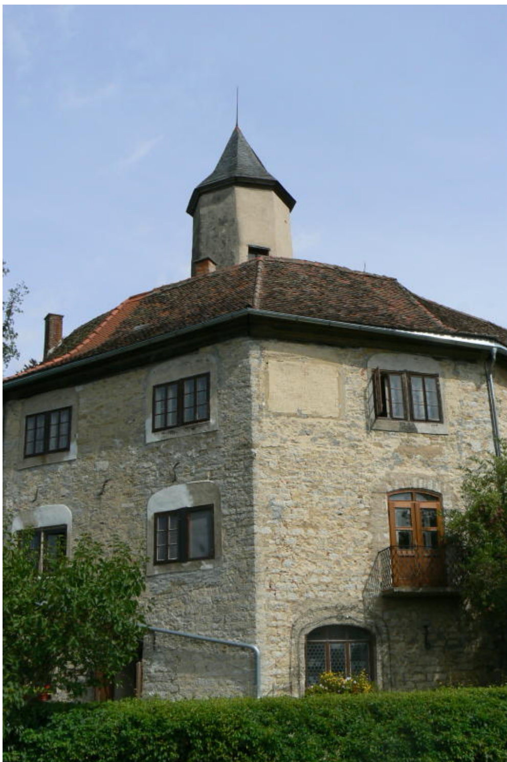
Südseite mit Treppenturm
