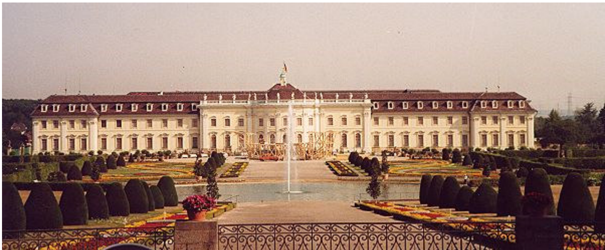
Neues Corps de Logis
