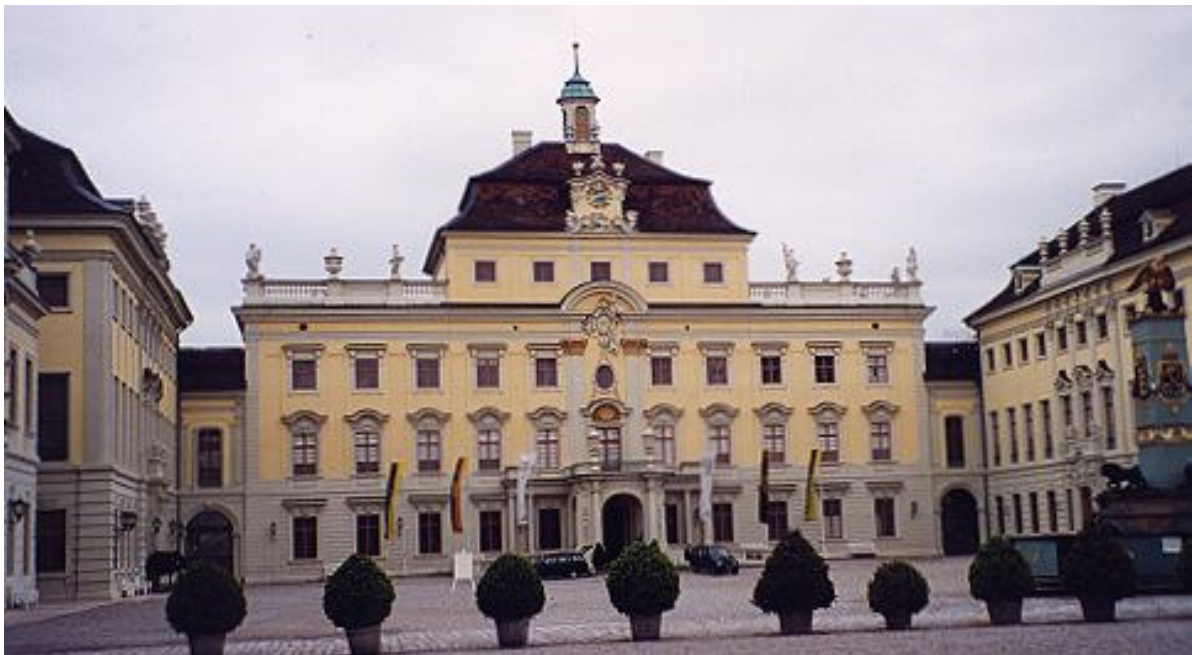
Altes Corps de Logis Südseite im Innenhof
