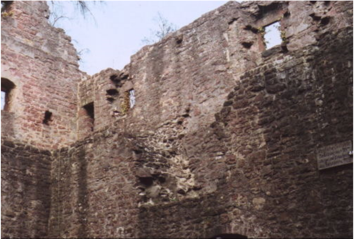
Ehemaliges Gebäude von innen (untere, mittelalterliche Mauern dicker)
