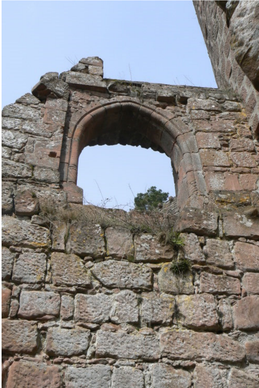
Früher Torzugang auf der Südostseite
