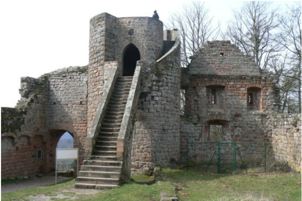
Flankierungsturm der Vorburg von Osten gesehen
