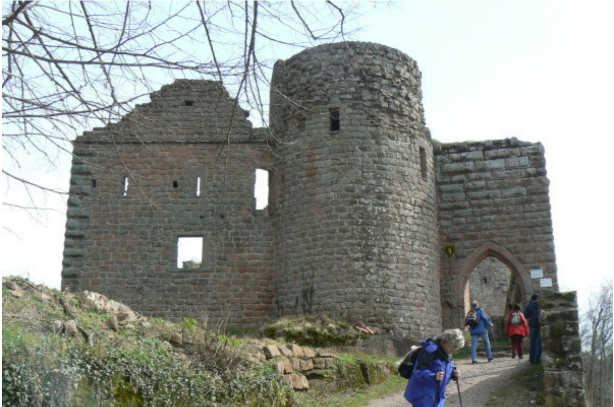
Vorburg mit Turm und Spitzbogentor von Westen gesehen
