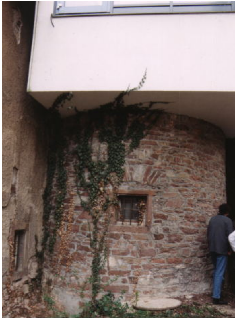
Alter Wehrturm im Norden (Maulscharten seitlich nicht sichtbar) mit dem aufgesetzten Neubau
