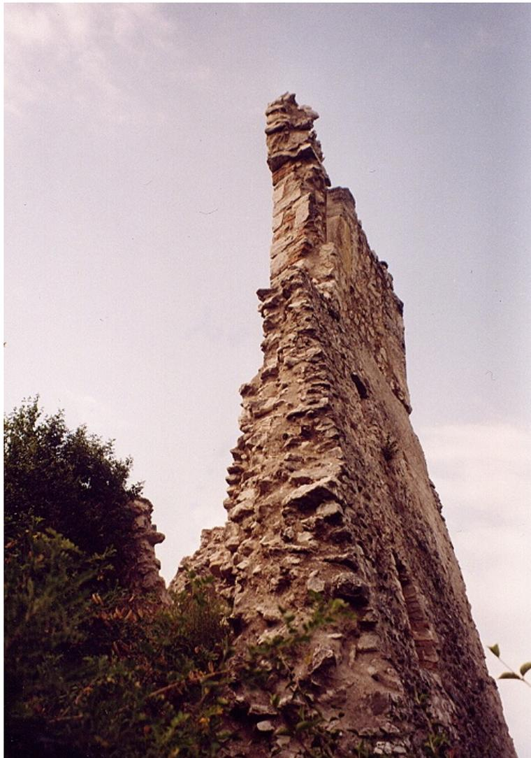
*Mauerzahn auf der Westseite mit keilförmiger Verdickung im unteren Bereich*
