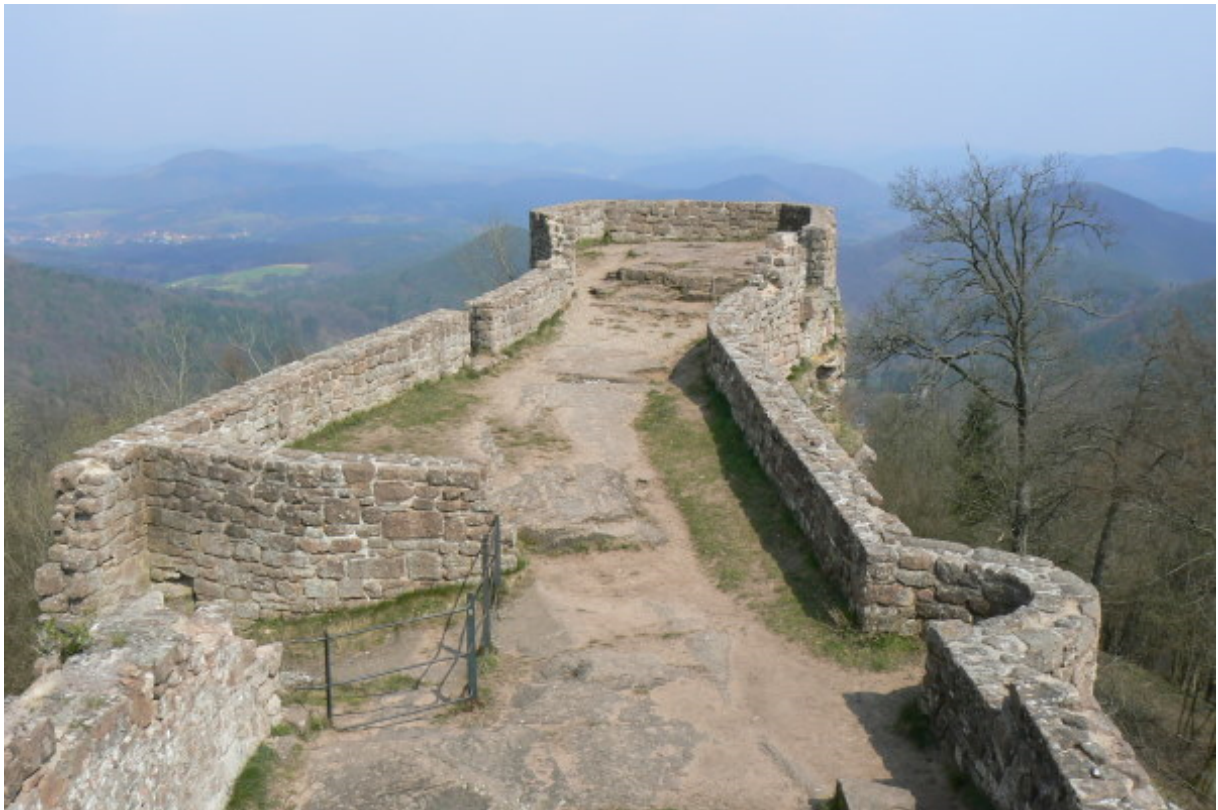
Nordostseite der Burg
